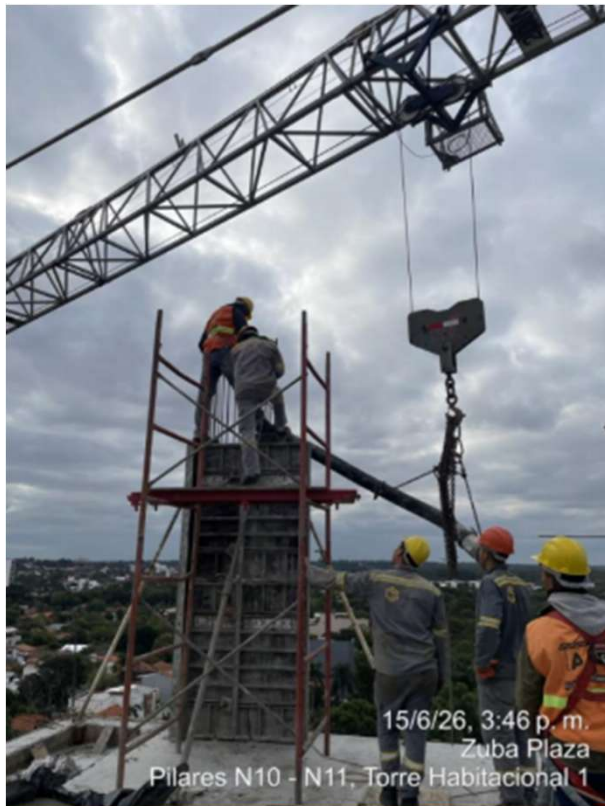
Cargamento de Pilares N10-N11 – Cargamento de Losa N10
