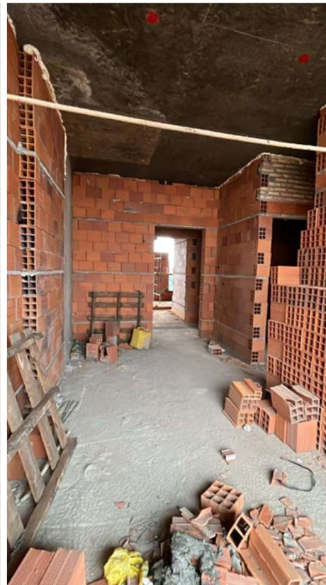
Elevación de mampostería en N5-N6-N7 – Revoque de mampostería en N2-N3-N4
