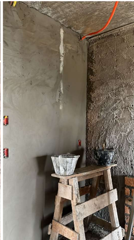
Elevación de mampostería en N5-N6-N7 – Revoque de mampostería en N2-N3-N4
